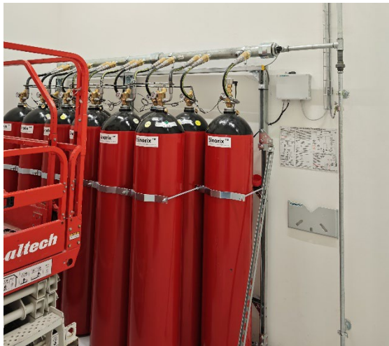
© safetyfocus GmbH- Löschbatterie
