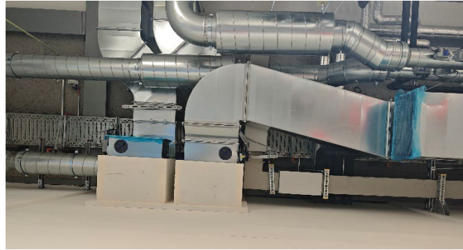
© safetyfocus GmbH - Abschottung Lüftungskanäle
